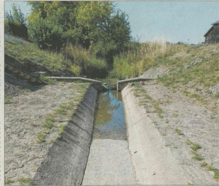
Das Wasser fehlt vielerorts, auch hier am Pegel in Binzwangen. Da die Rinne vertrocknet ist, sind Messungen nicht mehr möglich. Foto: Wasserwirtschaftsamt Ansbach/Gerd Kraub
